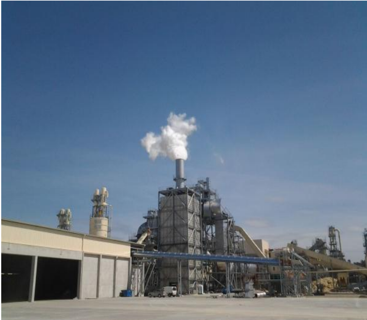
Anlage in Betrieb
