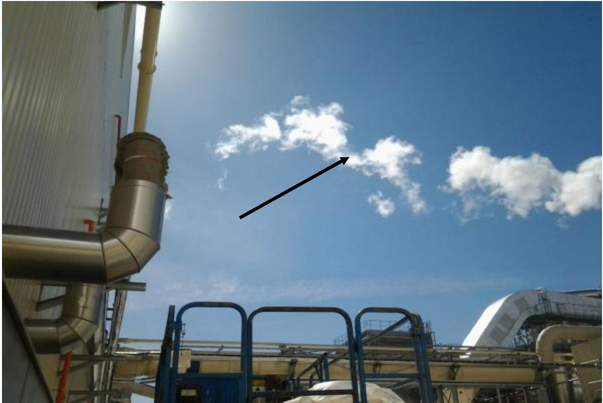
Hochspannungsfeld im Vollbetrieb , Venturi in Betrieb Ansicht vor dem Gebäude, kein Blue Haze
